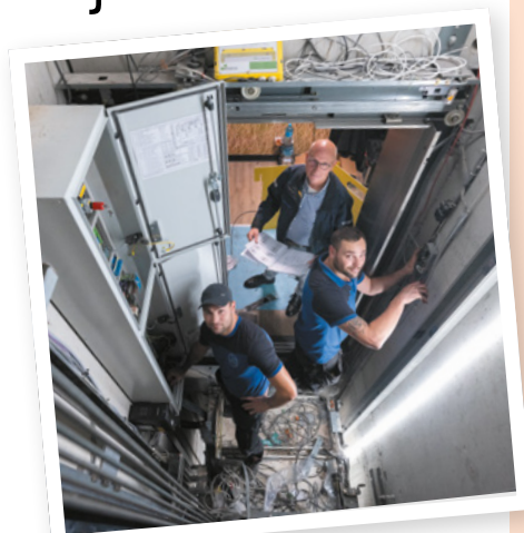
Ruud (projectleider, midden) houdt toezicht op de juiste uitvoering van de werkzaamheden.
